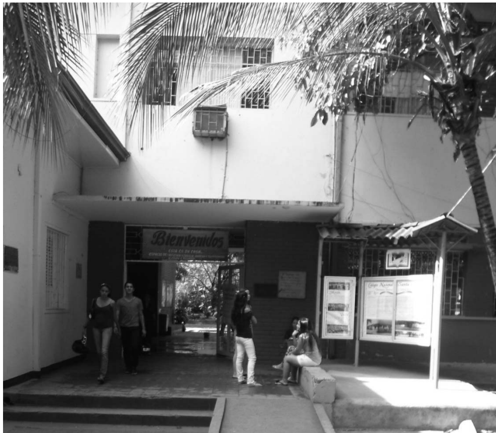
Hall de ingreso al interior del actual edificio del Colegio.
