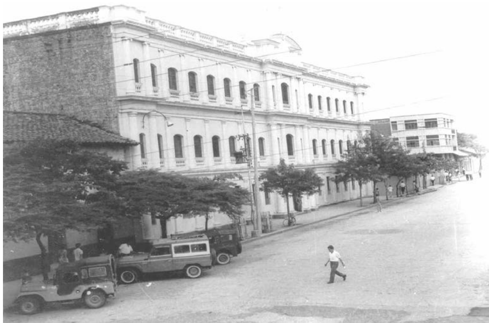
Figura 7. Edificio de la Gobernación del Departamento o palacio de las 56 ventanas Fuente: Archivo histórico fotográfico, Academia Huilense de Historia
